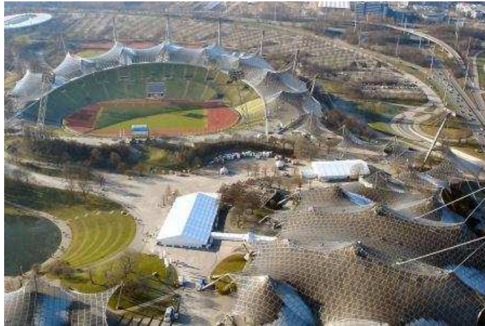
Figura 2.12 Cobertura do Estádio Olímpico de Munique. [11]
