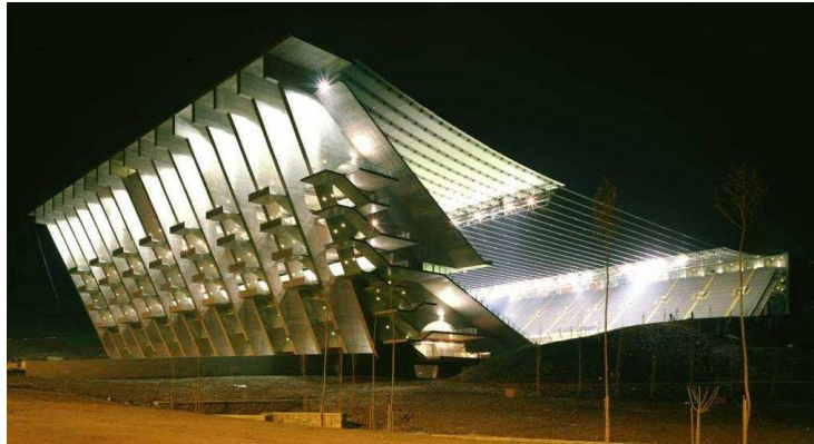
Figura 2.13 Estádio Municipal de Braga. [4]
