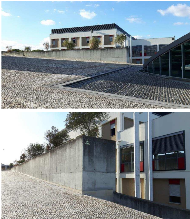
Figura 4.7 Paredes existentes na superfície da praça.
